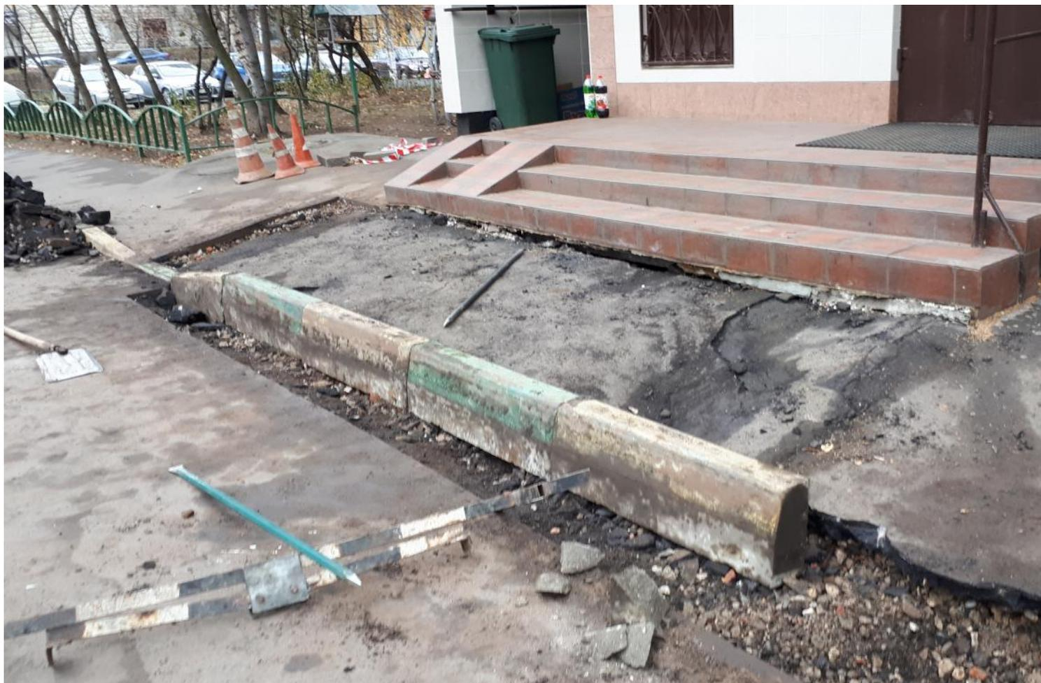
Сегодня начат ремонт тротуара перед 6 подъездом. Через день привезут бетон и укрепят бордюры, еще день для укладки толстого слоя асфальта. Отремонтированное ЖСК крыльцо и отремонтированный "Жилищником" тротуар будут долго радовать жителей подъезда.
